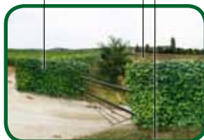
Le bassin de rétention existant : état possible après requalification (photomontage).
