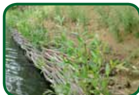
Exemples de fascines de boutures de saules vivantes et tressées, et assurant la tenue des berges d'un ruisseau.
