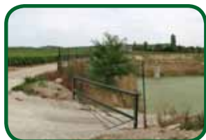
Le bassin de rétention existant : état actuel.
