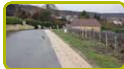
Exemple de revêtement de chaussées qualitatif réalisé sur un site à forts enjeux paysagers (abords de l'abbaye d'Hautvillers) : bande de béton désactivé et de couleur claire bordant la route à l'entrée du village.
