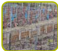
Exemple de petit soutènement réalisé en tunage de bois. (© creylachapelle.eu)
