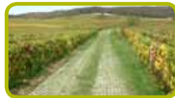
Chaussée enherbée à structure renforcée, une expérimentation en cours sur la commune d'Ambonnay.
