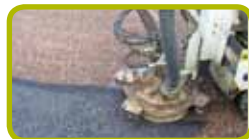
Hydro-décapage d'une surface d'enrobé neuf (photo Eurovia), un procédé faisant ressortir la couleur des granulats et permettant d'obtenir des chaussées de teinte sensiblement plus claire que les enrobés non traités.
