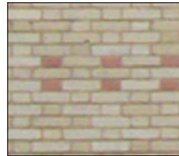
Mur en brique
