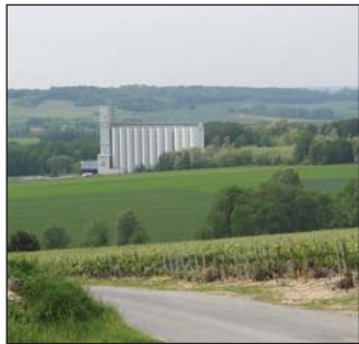
Silos de Sery-et-Pin
