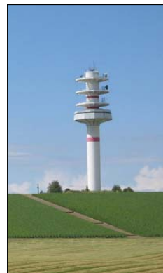
Poteau de télécommunication de Glannes
