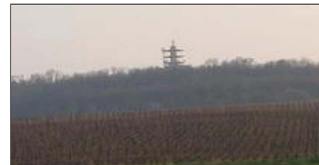
Poteau de télécommunications du Mont de Berru, Nogent l'Abesse
