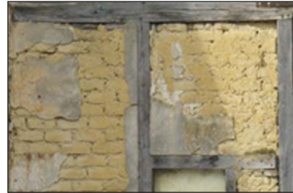
Maison à pans de bois, carreaux de terre
