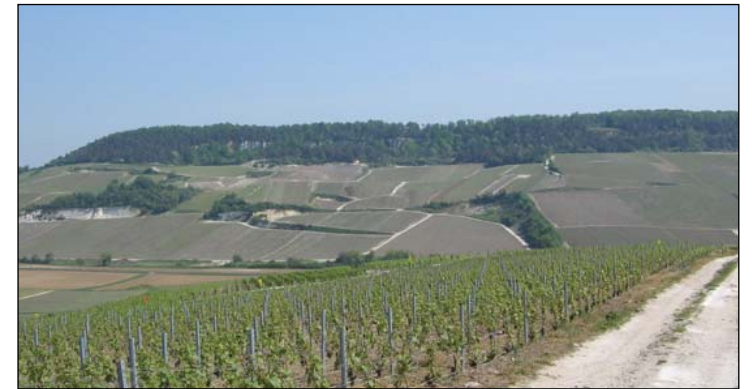
Vignobles de Cuis et de Mancy, coteau remodelé
